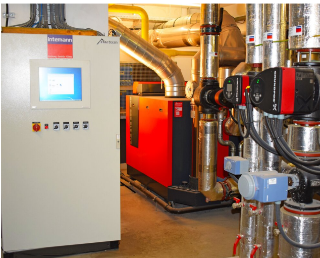
Zwei bösch Gas-Kessel 310/680-Pro sorgen für angenehme Arbeitstemperaturen bei IMA SCHELLING. Alle Geräte werden über die bösch Gebäudeleittechnik gesteuert und arbeiten deshalb besonders effizient.
