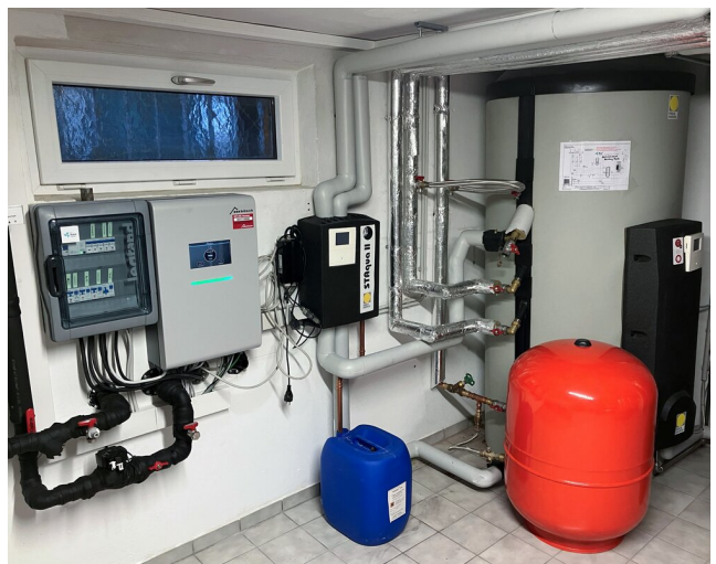
Blick in den Heizraum: Pufferspeicher und Hydraulik der modernisierten Heizungsanlage. Der Wärmepumpenmanager steuert Heizung, Warmwasser und Kühlfunktion der Anlage.
